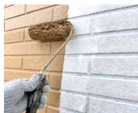
外壁を綺麗にしたい
